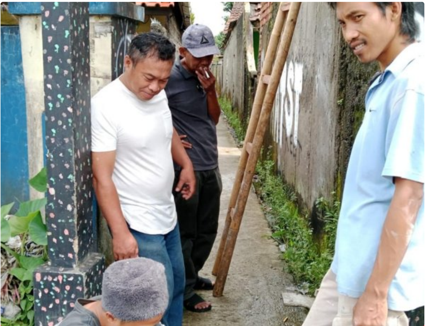
Warga di Cibadak Gotong Royong Pasang Lampu Jalan Gang
