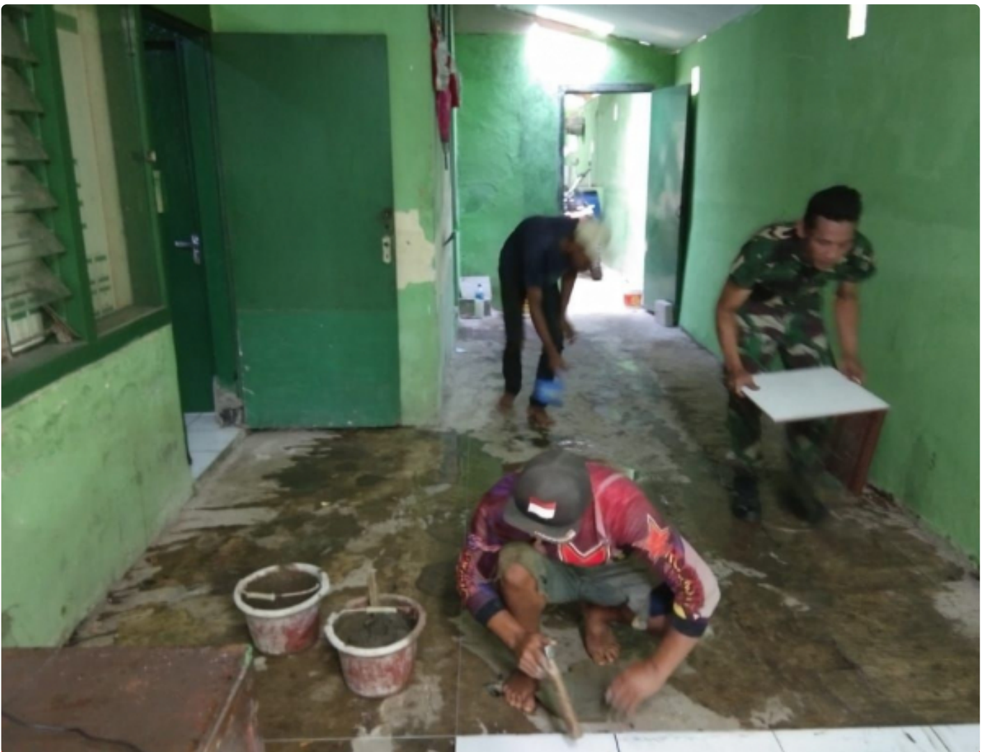
Koramil 0622-04/Cikidang Lakukan Perbaikan dan Pemeliharaan Kantornya
